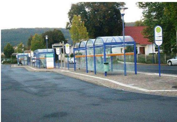
**Abb. 9:** Die Ausführung eines Busbahnhofs als Mittelinsel, wie in Michelstadt, ist in vielerlei Hinsicht vorteilhafter als die Variante mit separaten Inseln pro Bussteig.
